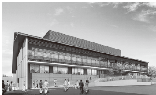
「仮称」市民交流プラザ外観【南側】
