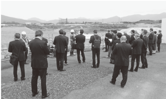
中部総合車両基地建設工事現場で説明を受ける様子
