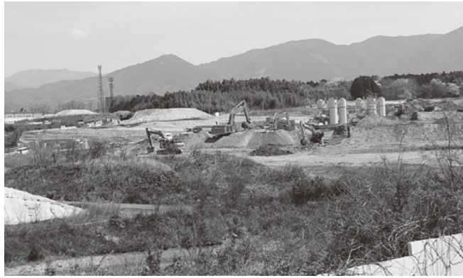
中部総合車両基地建設工事現場
