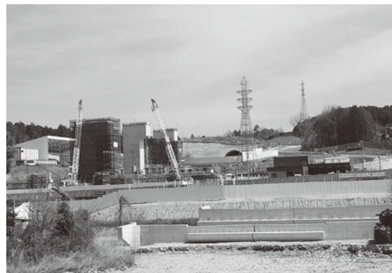
岐阜県駅建設工事現場
