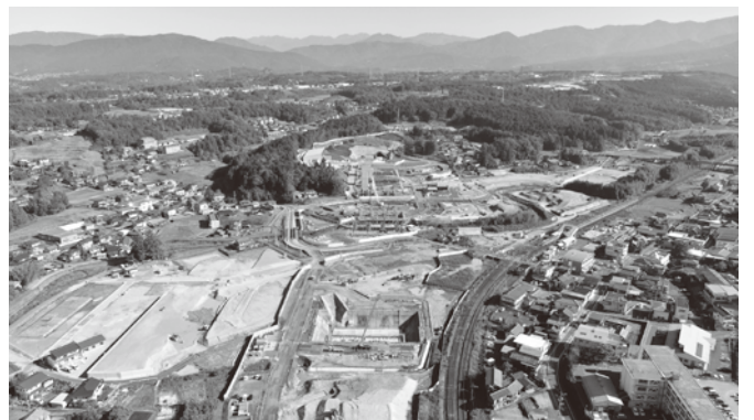
リニア岐阜県駅周辺の工事状況(11月時点)
