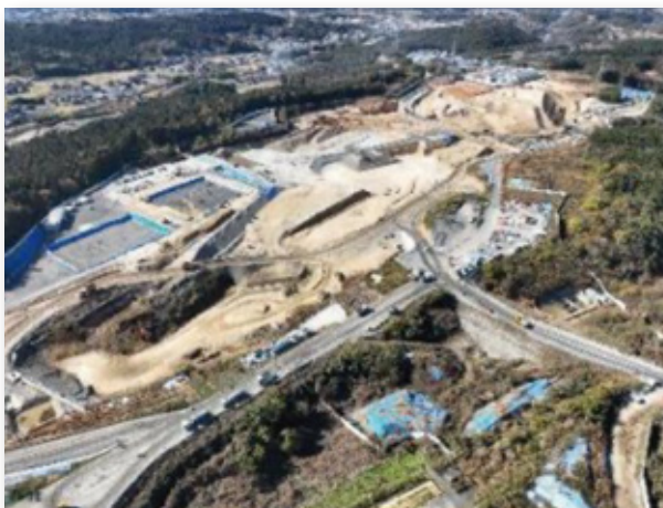
中部総合車両基地
