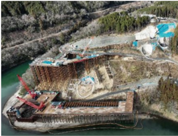
第一木曾川橋りょう
