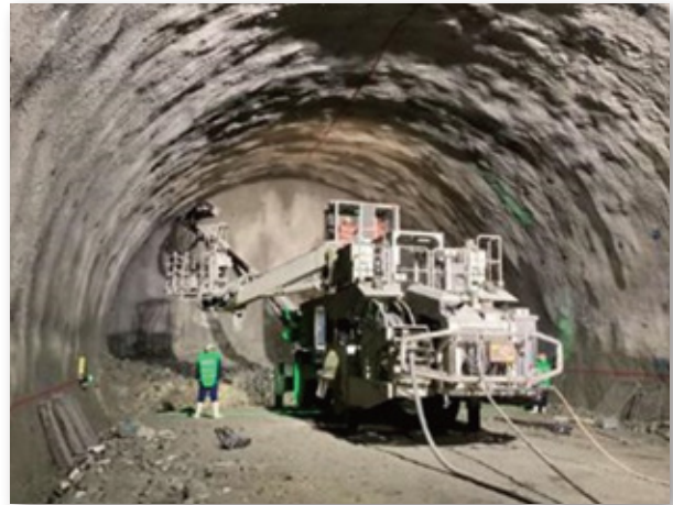
瀬戸トンネル
