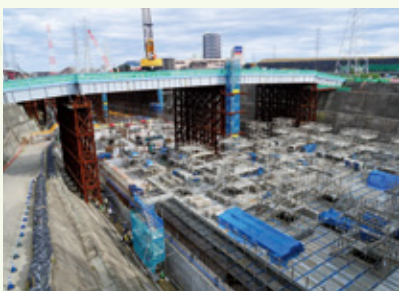
神奈川県駅(仮称)工事現場
